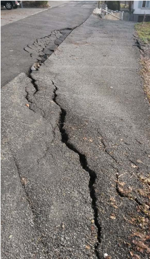
Spontaner Rutsch um den 21.01.18, Verschiebung vertikal ca. 20cm
