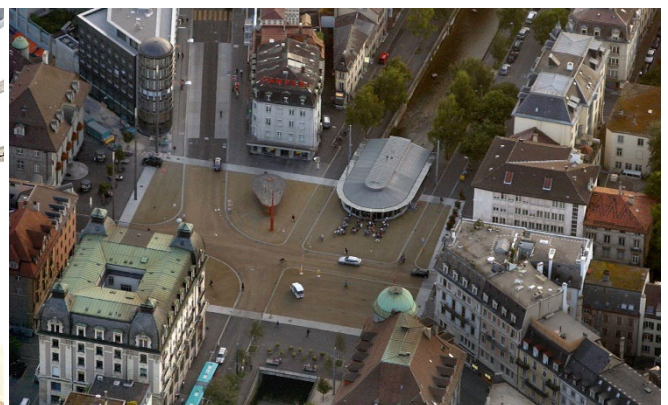
Abbildung 31: Biel, Zentralplatz (Platzgestaltung mit dezenter Verkehrsführung)
