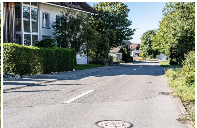
Abbildung 14: Bärswilstrasse, Einmündung Sägeweg (Einmündung kaum wahrnehmbar)
