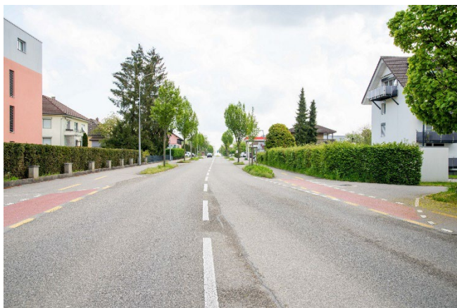
Abbildung 6: H5, Blick Ri Knoten Gassackerweg (Veloführung auf Trottoirniveau mit Sichthindernis)
