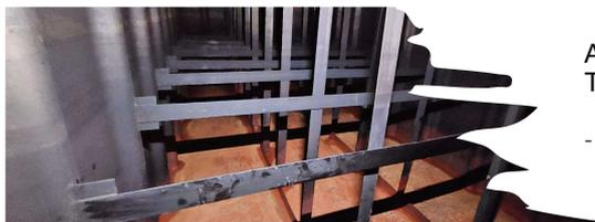
Alter Öltank umfunktionieren in eine Thermobatterie
