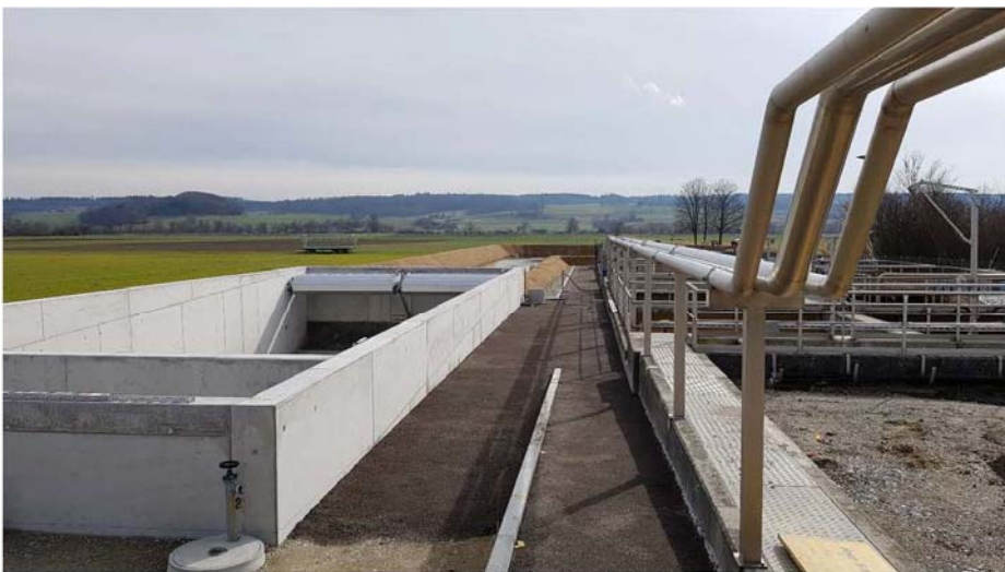
Rückhaltebecken und Umgebung Alt - Neu
