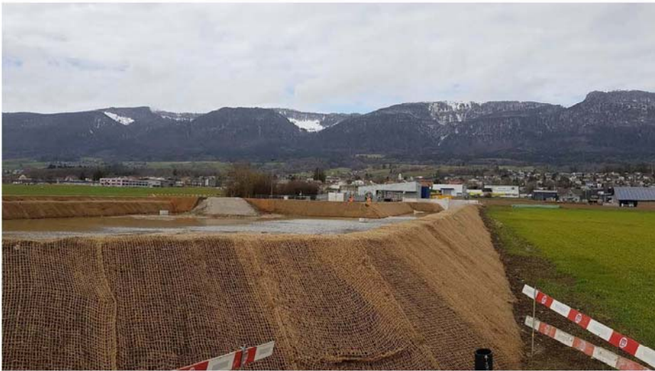
Retentionsbecken von Süden mit Dammüberfahrt
