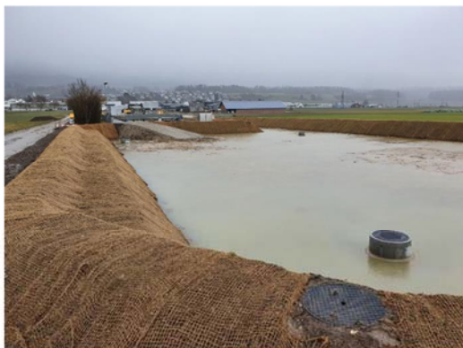
Foto 2: Retentionsbecken mit hochliegender Zugangsfurt
