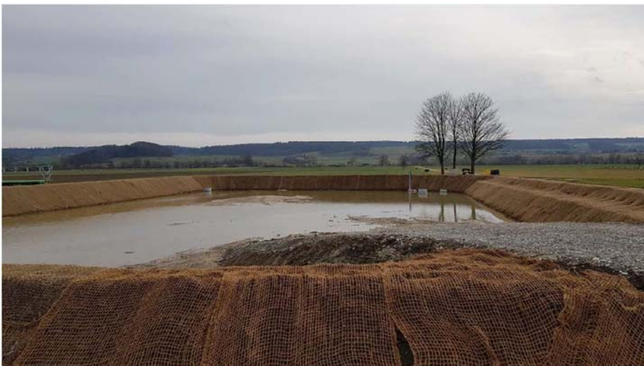
Retentionsbecken von Norden
