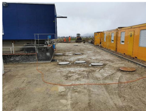
Foto 3: Rohplanie nördlicher Vorplatz
